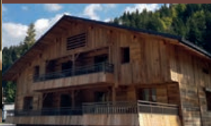
Chalet «Maison l'Escale»
